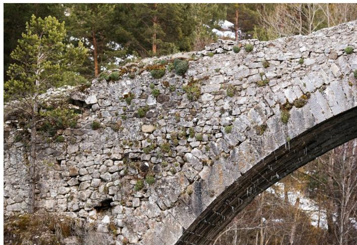
Les travaux proposés sont la dévégétalisation de l'ouvrage et des abords et le confortement des structures (reconstruction des maçonneries effondrées, consolidation des maçonneries et du rocher support ...). Dans un second temps, il est proposé la réfection du revêtement permettant l'évacuation des eaux de ruissellement et la restitution des parapets selon les dispositions anciennes. Un reprofilage des abords du pont permettra sa mise en valeur.
